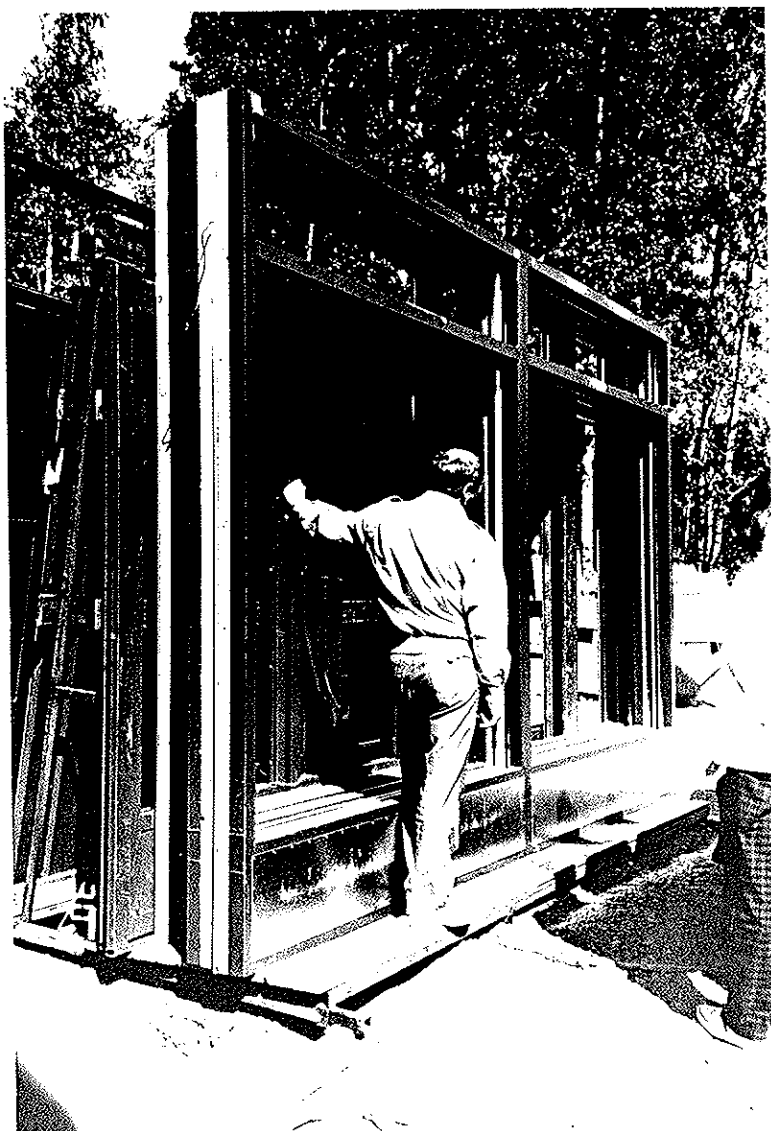
Kuva 1. Maanpinta vietti rakennuksesta poispäin paikassa, johon T-pukki elementteineen sijoitettiin.
