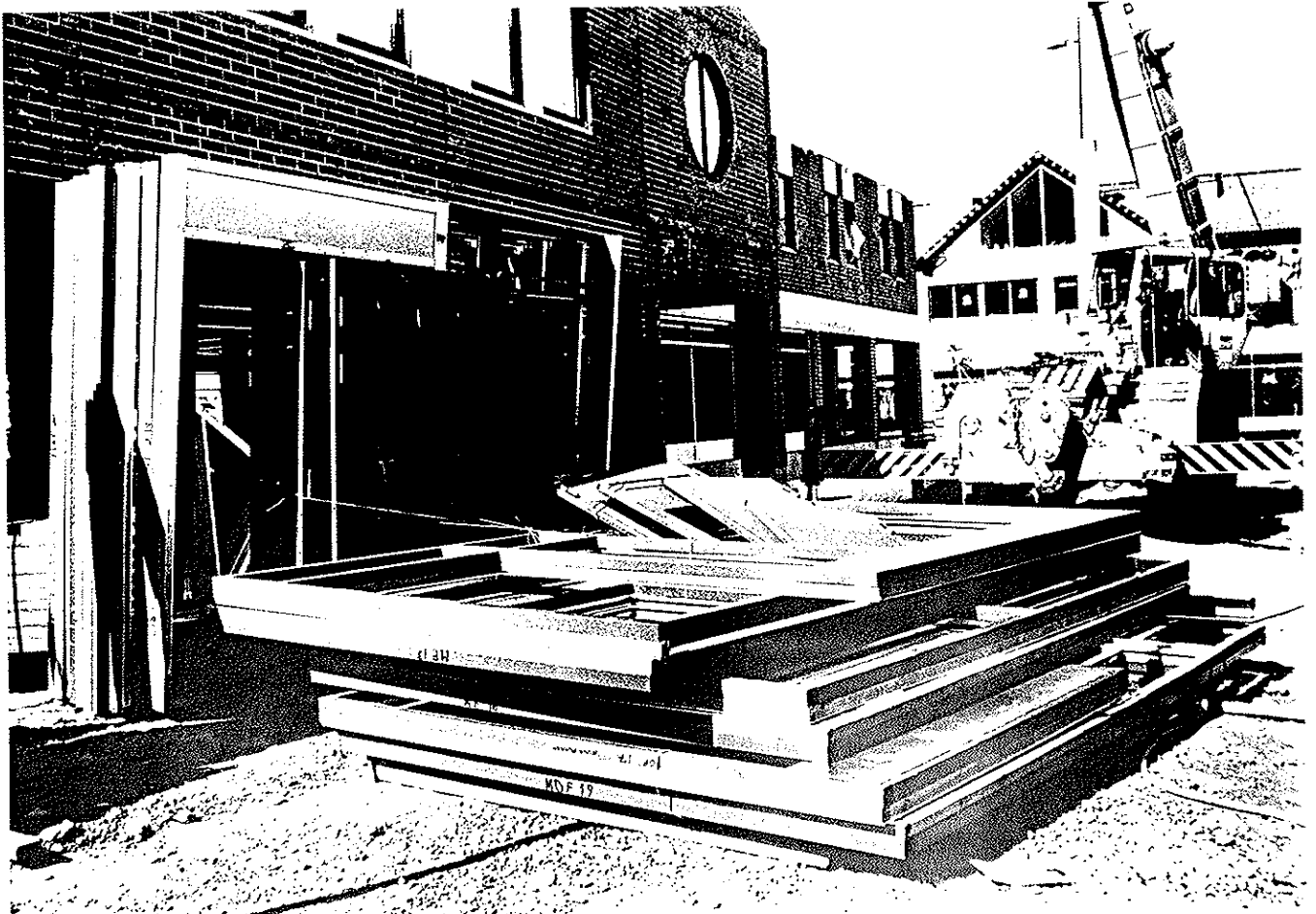
Kuva 4. Kaatuneet elementit tapaturman jälkeen
