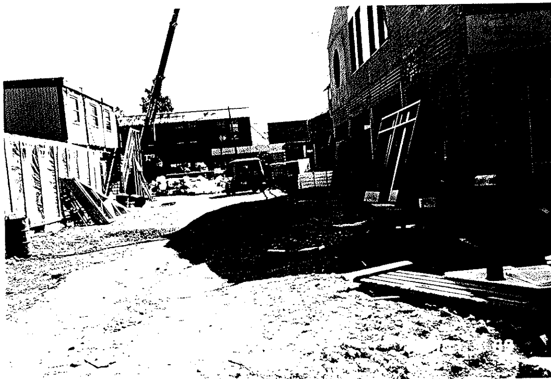
Kuva 1. Maanpinta vietti rakennuksesta poispäin paikassa, johon T-pukki elementteineen sijoitettiin.
