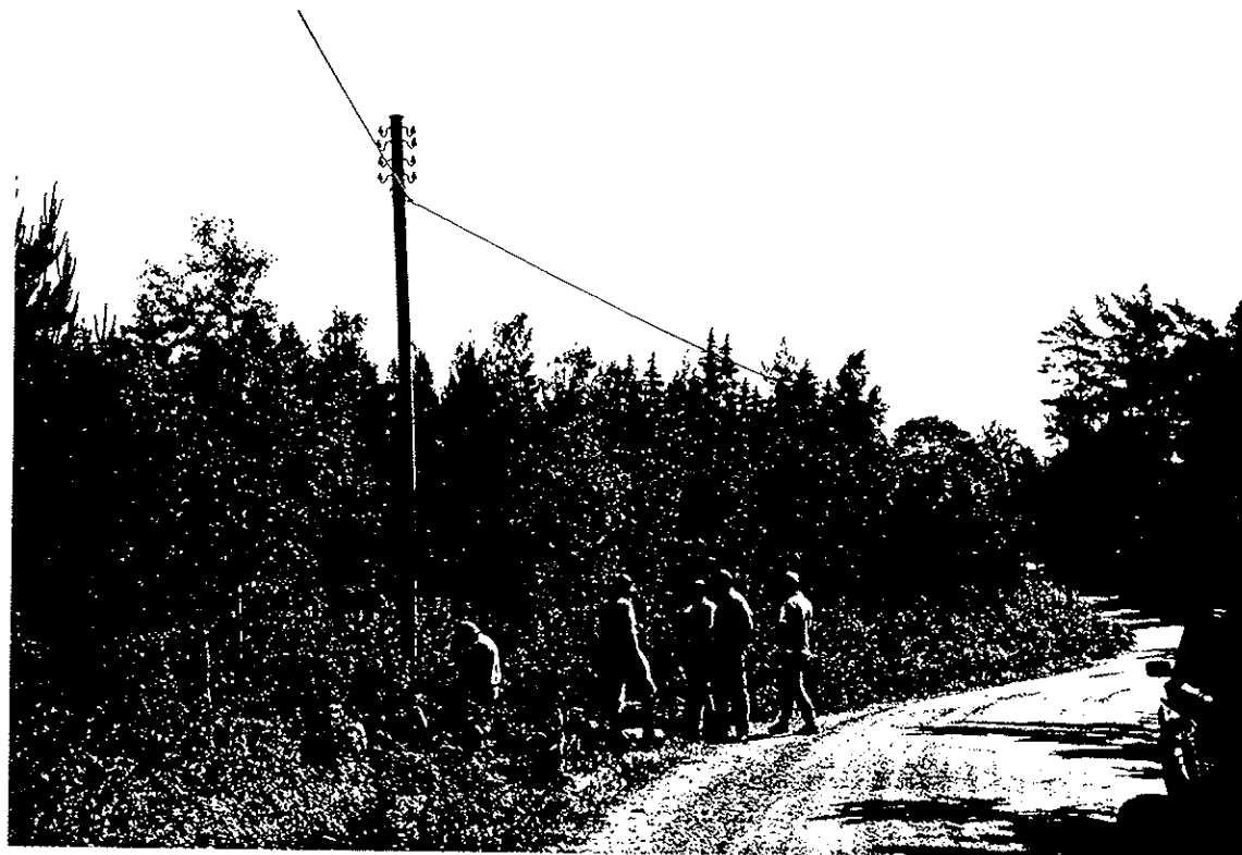
Kuva 1. Työtaturman sattumispaikka - uusi pylväs
