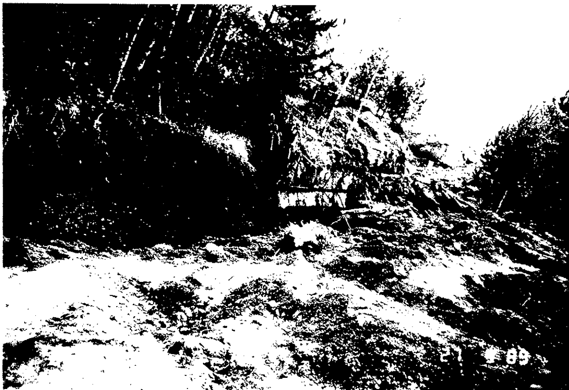
Kuva 1. Valmista kaivantoa. Tässä kohdin maa on hiekkaa. Kaivantoon on kertynyt vettä.
