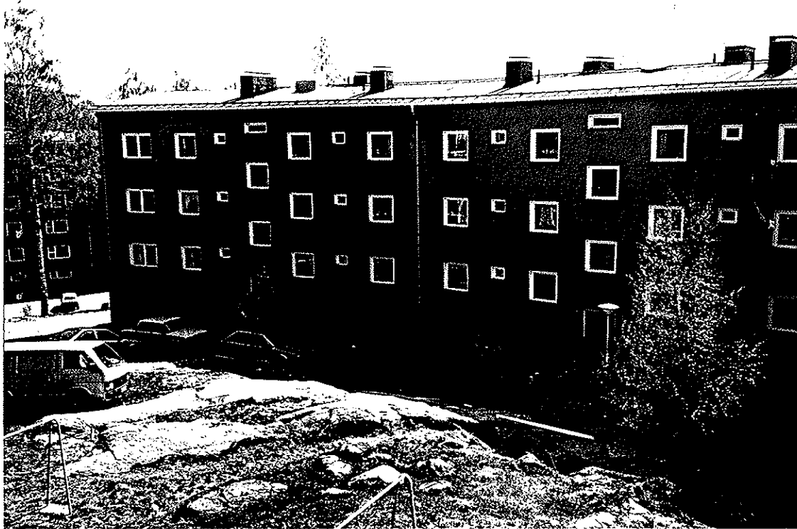
Kuva 1. Talo, johon räystäskouruja asennettiin
