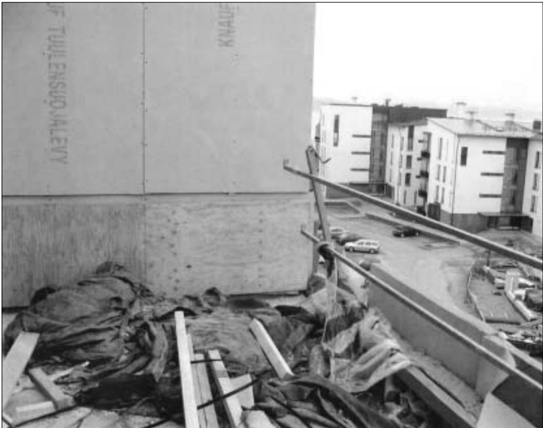
Kuva 2. Parveke, levytetty päätyseinä.
