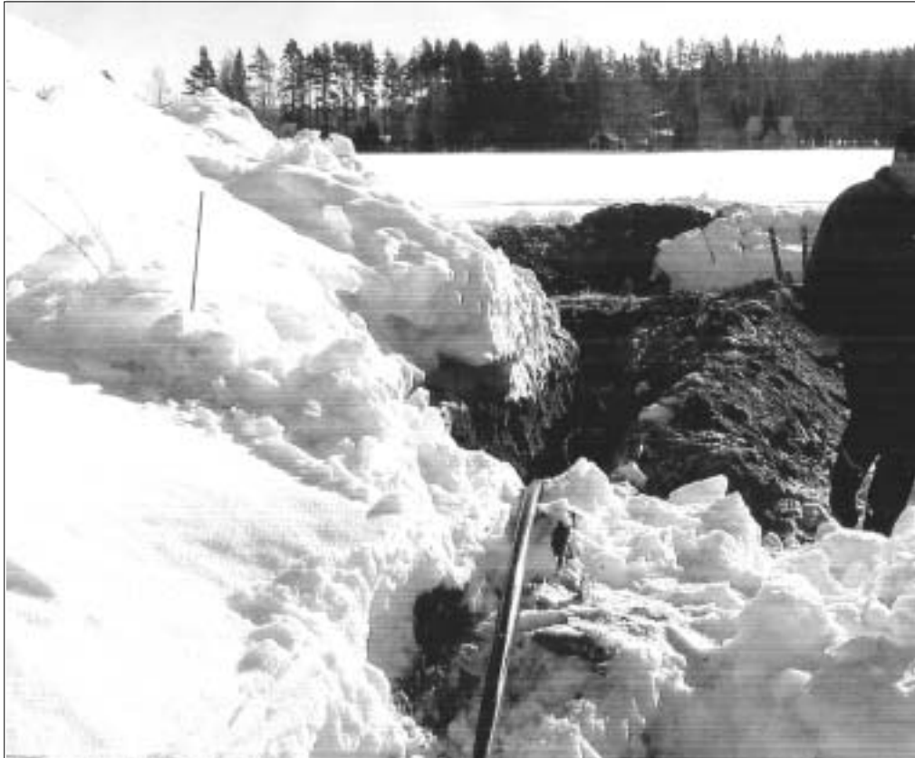
Kuva 3. Kuvattu kuivurirakennuksesta päin. Taustalla tien alitus.
